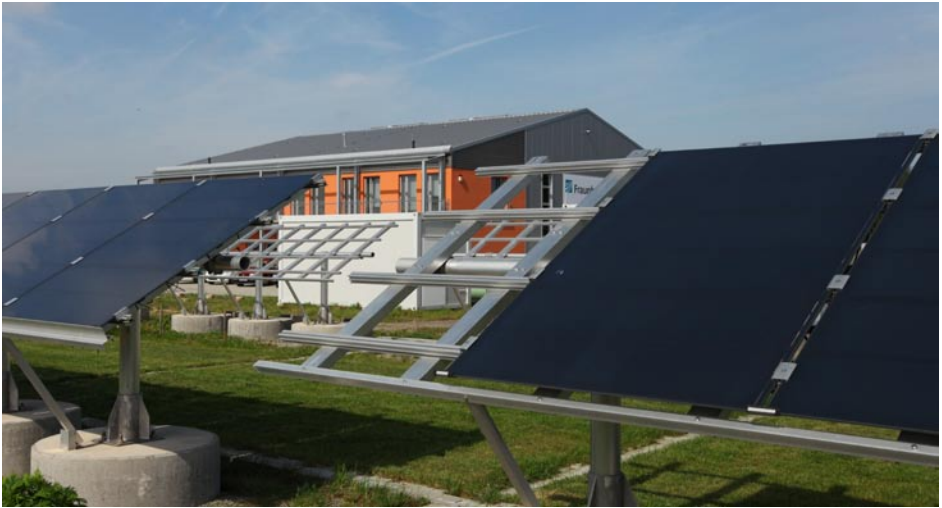
Bild 7: IWES-SysTec mit PV-Testfeld und Laborhallen für Netzintegration
